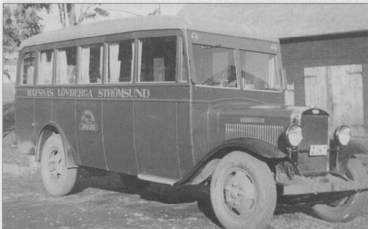
Volvo 1934 6 cyl.motor typ EB på 65 hk.
